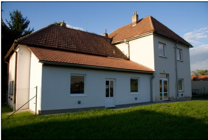
Přístavba obecní knihovny – čp.41
